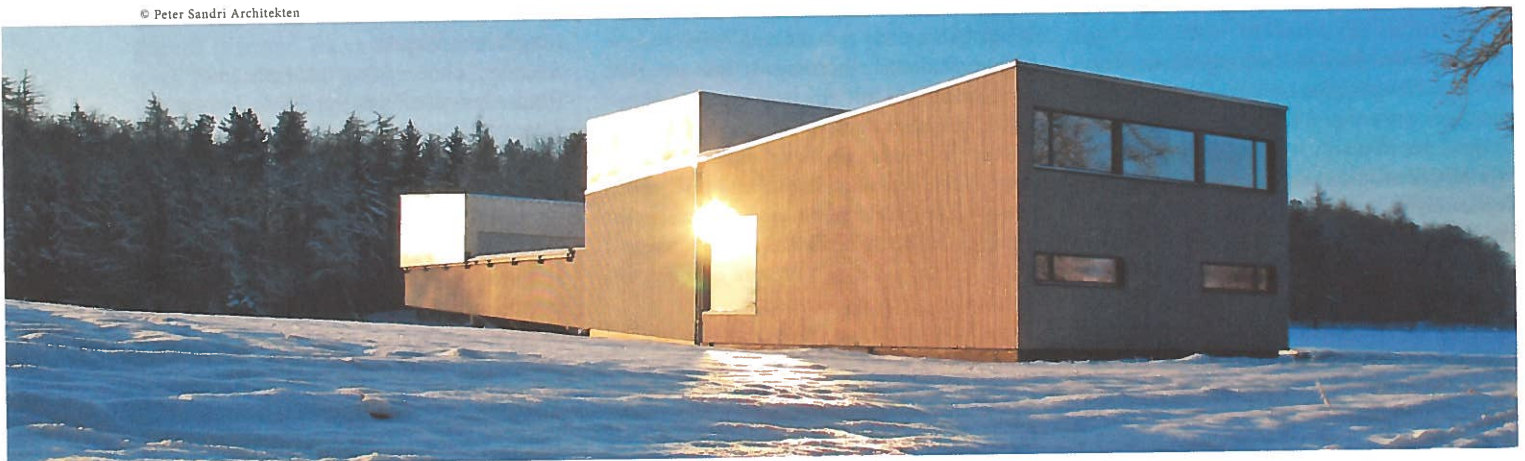
Die neue Sternwarte Schaffhausen (CH) von Architekt Peter Sandri scheint sich durch die Aufständigung auf zwei Formstützen vom Feld förmlich abzuheben. Gebaut in einem vorgefertigten Holzsystem, stellt es ein Musterbeispiel der Vernetzung zwischen Architekten, Holzbauern und Sponsoren dar.
